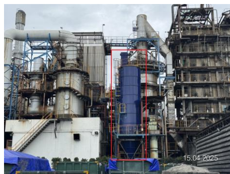
ภาพที่ 2-12 Activated Carbon Injection และ Dry Scrubber (Lime Silo)
