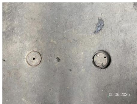
ภาพที่ 2-24 บ่อสังเกตการณ์น้ำใต้ดิน (Groundwater Monitoring Well)
