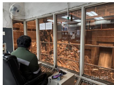
ภาพที่ 2-8 บ่อรวบรวมของเสีย (Refuse Pit)
