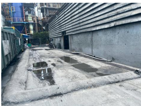
ภาพที่ 2-29 คันคอนกรีต (บริเวณพื้นที่เก็บของเสียที่เป็นของเหลวไม่อันตราย)
