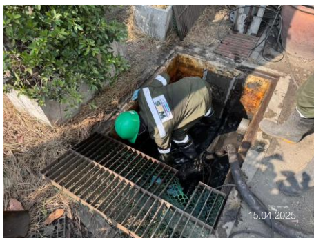
ภาพที่ 2-39 การทำความสะอาดบ่อพักน้ำฝน
