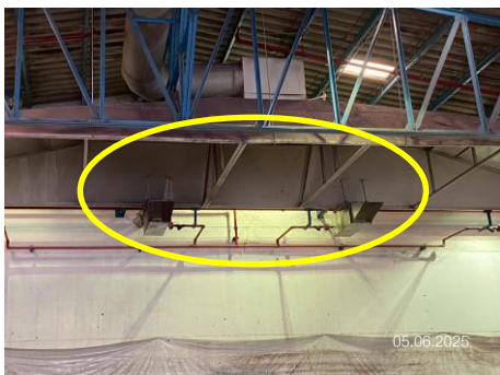
ภาพที่ 2-3 ระบบดูดอากาศ บริเวณส่วนจัดการของเสียอันตราย
